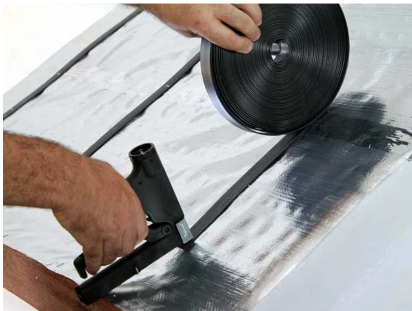
Figura 6. Fixação da manta utilizando fixador de polipropileno.
